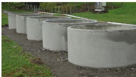
Les bacs de collecte au moment de leur pose
